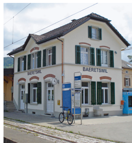
Denkmalgeschützt: der Bahnhof in Bäretswil.
