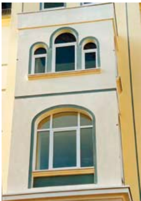
Preparazione delle finestre con vernici a base di resina silconica in una abitazione in Gera (Türingen, Germania).
