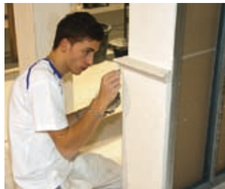
Die Gipser mussten ein Portal in Leichtbauweise konstruieren. Perfekt geglättete Putzoberflächen und Stuckaturen gehörten mit zur Aufgabe.
