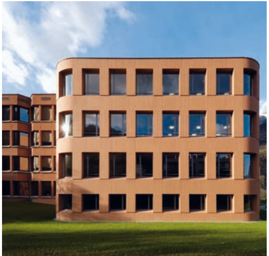
Vorne neu, hinten links alt: Durch das exakte Nachmischen der Lasur Keim Concretal gemäss dem Farbton des Bestands konnten Farbabweichungen zum Neubau vermieden werden. (Bild: Ralph Feiner, Malans)
