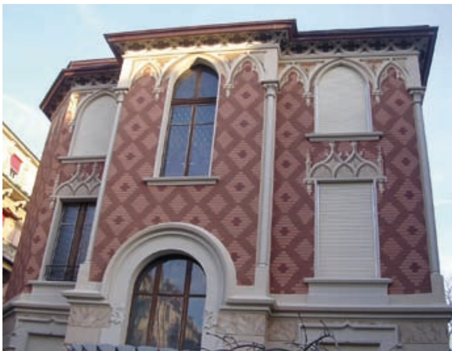
Die perfekte Illusion: Die Backsteine sind keine Backsteine, der Marmor ist kein Marmor, die gewölbte Dachuntersicht ist nicht gewölbt. (Bild: Sax)
