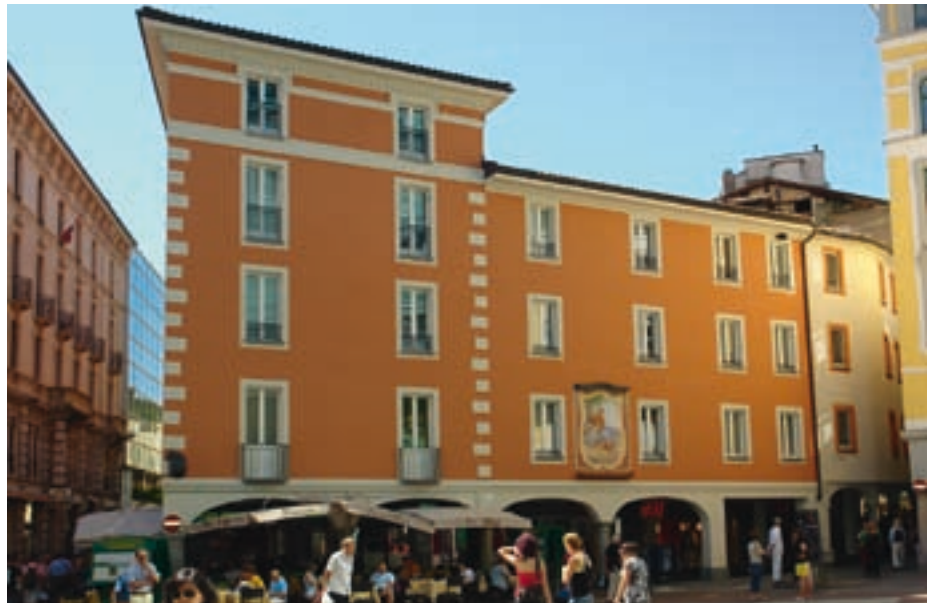
Die Farbtöne «Salmone Arancio» und «Grigio Gronda» des Beschichtungssystems Dolwasil von Dold bringen südliches Ambiente auf diese Fassade in Lugano. (Bild: Dold)
