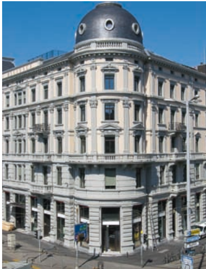
Imposantes Grand Hotel Bellevue in Zürich: Die Fassade und alle Dekorelemente wie Bänder, Laibungen und Pilaster wurden mit Exposit-Silicon-Mineralfarbe von Bosshard gestrichen. (Bild: Bosshard)
