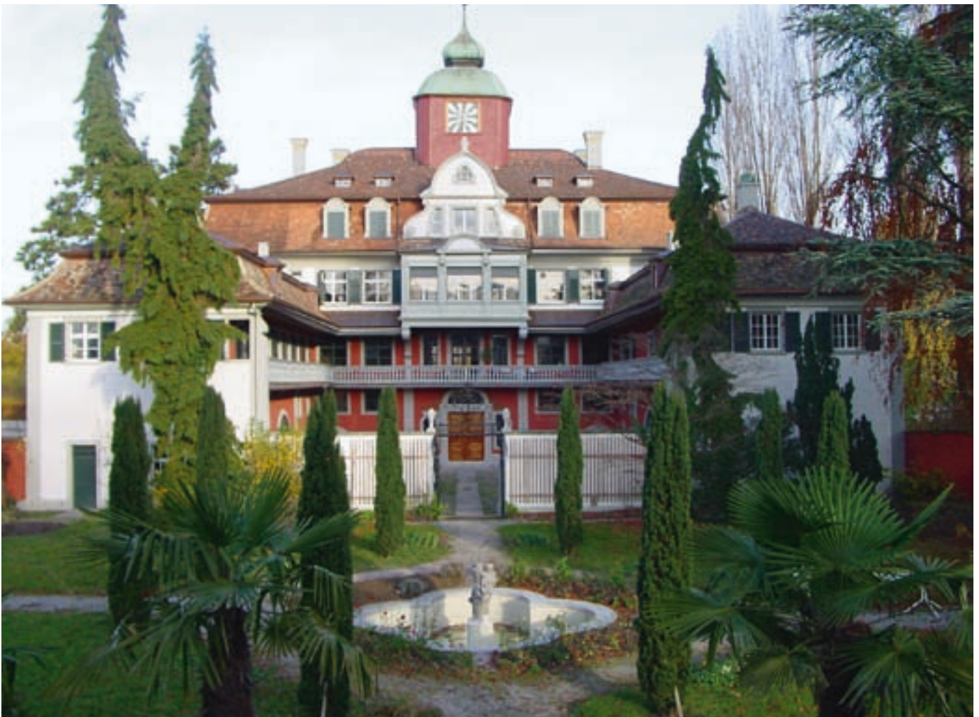
Bei der Sanierung des Löwenhofs im Jahr 2007 wurde auf die Substanzerhaltung grosser Wert gelegt und die Fassade deshalb von Grund auf mit dem System Novalith APS wieder mineralisch aufgebaut. (Bild: Kabe)
