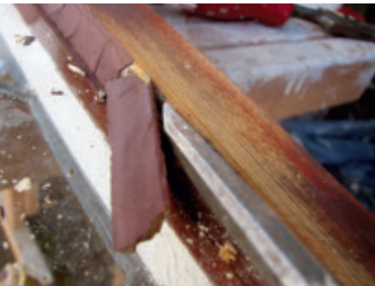
Heikel: Der zum Teil lose Fensterkitt musste vorsichtig entfernt werden.
