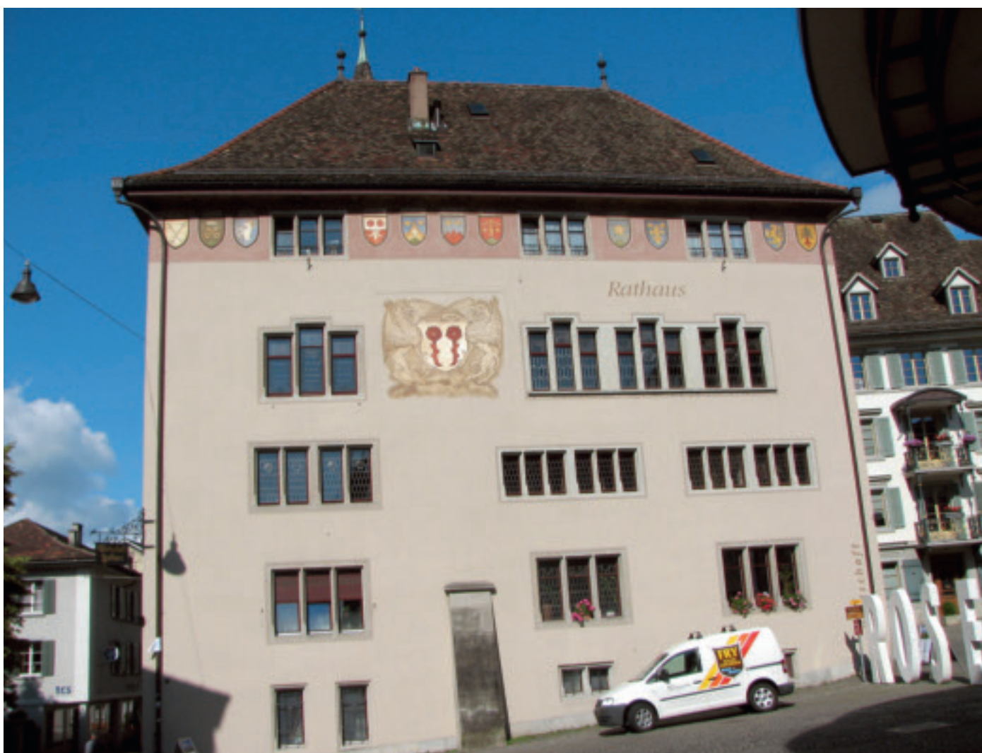
Imposant: Das Rathaus von Rapperswil-Jona mit seinen unzähligen Fenstern, welche restauriert werden mussten.
