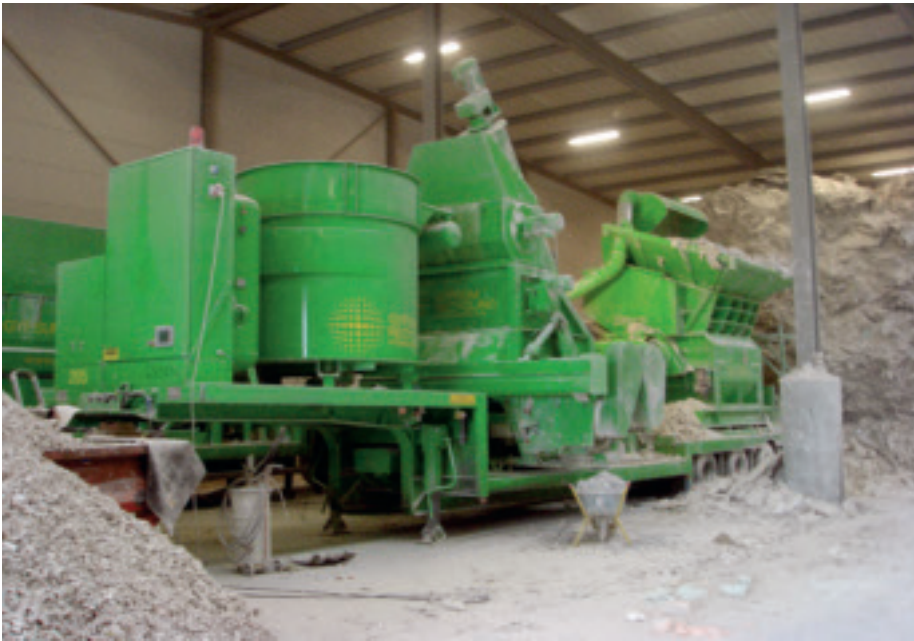
Eine Recyclinganlage verarbeitet die Gipsabfälle und trennt sie in Gips, Papier und Metall. Die Qualität der gewonnenen Recyclingprodukte ist so hoch, dass sie alle wieder in einen Produktionsprozess zurückgeführt werden können – 100% Recycling.
