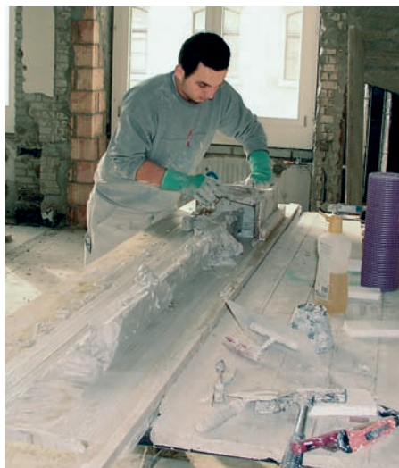
Lehrling Sead Mulolli beim Ziehen von Profilen.
