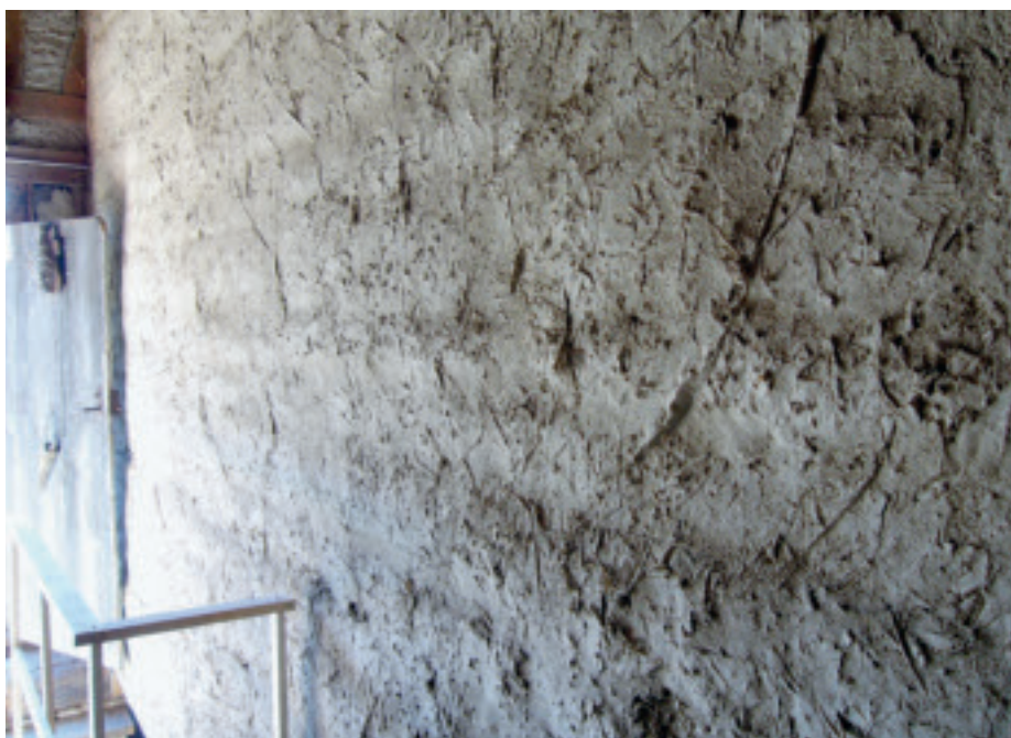
Grober Lehmputz auf einer Strohballenwand.
