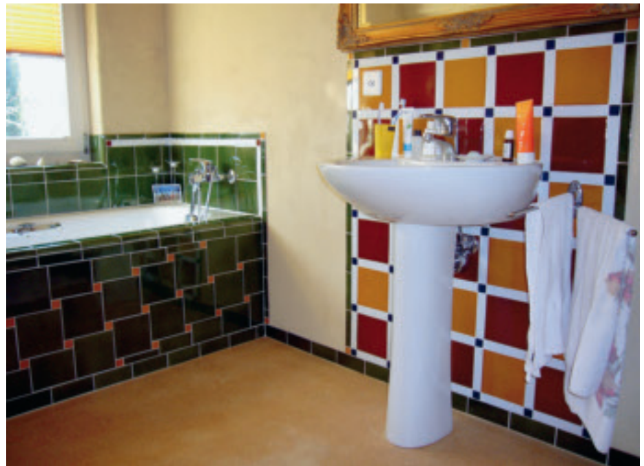
Lehm lässt sich auch in Feuchträumen applizieren. Spritzwasserbereiche müssen aber geschützt werden, z. B. wie hier mit Wandfliesen.
