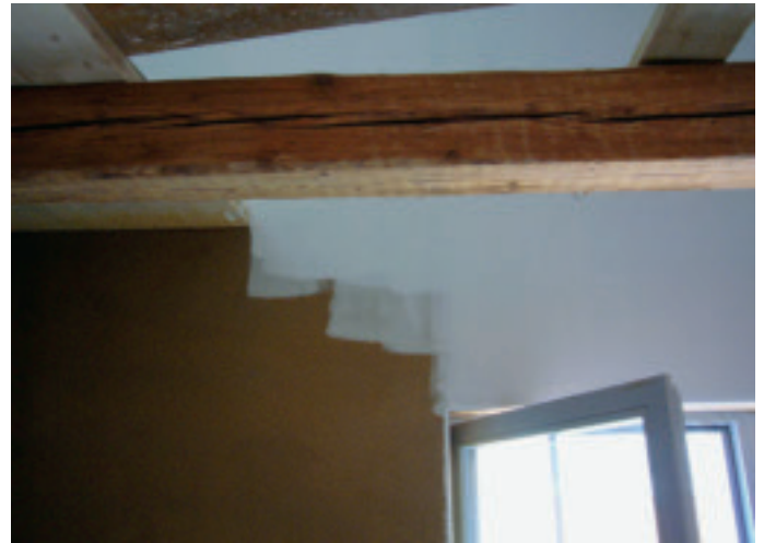
Wände mit Lehmputz können gestrichen werden, z. B. mit Kaseinfarbe.
