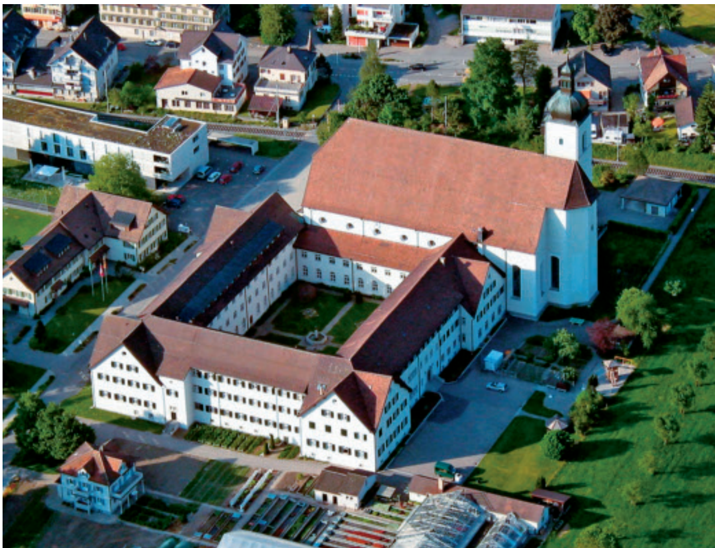
Das ehemalige Benediktinerkloster in Neu St. Johann dient heute zur Hälfte dem gemeinnützigen Verein Johanneum. Seine Fassaden wurden 2003/2004 umfassend saniert (Blickrichtung nach Norden).
