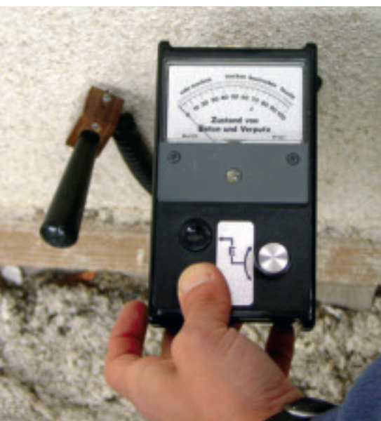
Vor dem Streichen des neuen Verputzes wurde der Untergrund eingehend geprüft, unter anderem auf Feuchtigkeit.
