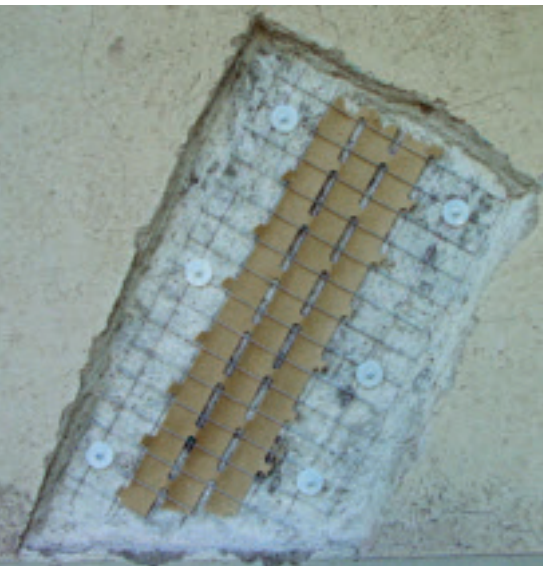
Risse wurden fachmännisch saniert.
