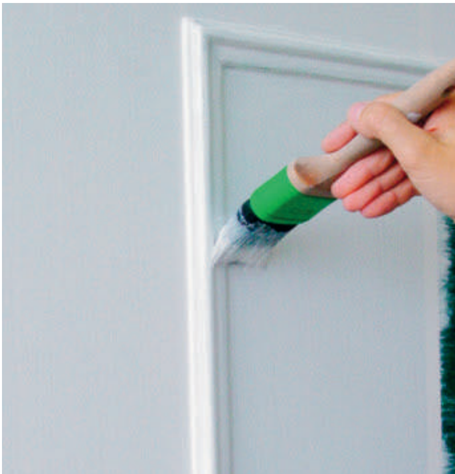
Die neueren wässrigen Baumalerlacke haben Offenzeiten, die auch für grössere Flächen reichen.
