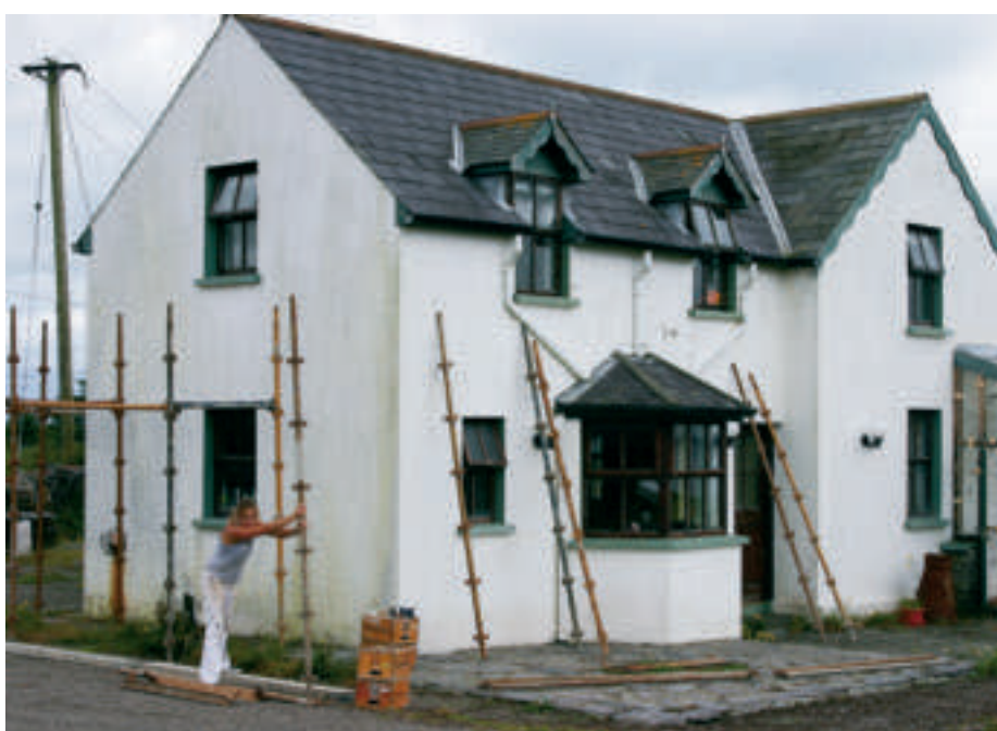
Dieses renovationsbedürftige Einfamilienhaus in Irland war im Rahmen eines Lehrlingsprojektes der Meier Schmocker AG von jungen Berufsleuten neu zu gestalten.
