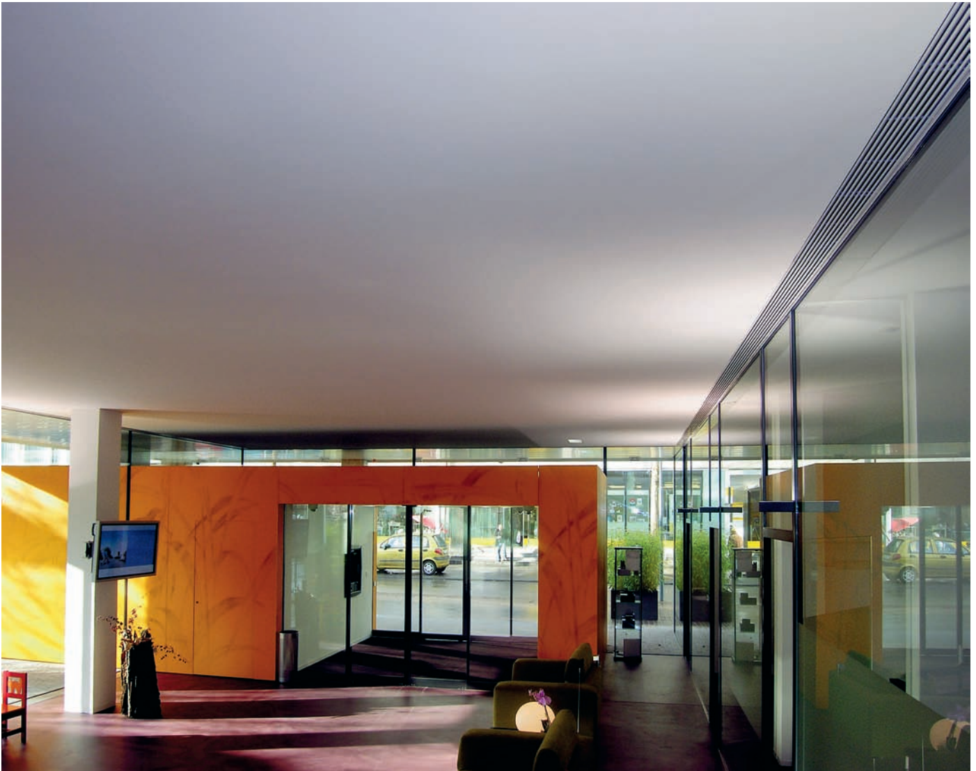
In der neuen Filiale der Raiffeisen-Bank in Burgdorf dämpft eine fugenlose, abgehängte Akustikdecke die Geräusche in der Eingangshalle.
