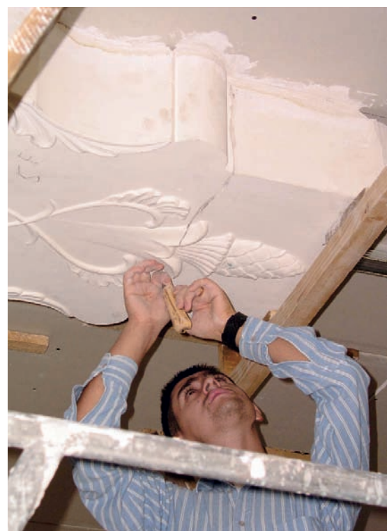
Vollendung: Gipser Burim Imeri putzt Rissbildungen zu.
