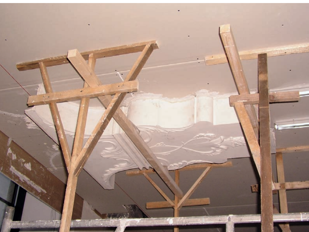
Präzise: Die grossen Stuckfragmente mussten mit Hilfskonstruktionen millimetergenau ausgerichtet werden.
