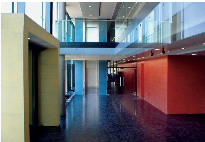
Sowohl aussen als auch innen wurde der Beton dieses Gebäudes mehrmals mit einer stark verdünnten silikatischen Dünnschichtfarbe lasiert, die eine Hydrophobierung beinhaltet. (Foto: Peter de Kleine)
