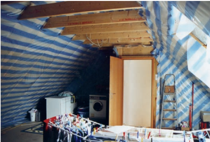
1 Dachgeschosse mit Kehlbalckenlage weisen eine Vielzahl von Durchdringungen auf, eine fachgerechte Abdichtung ist wirtschaftlich nicht möglich.
