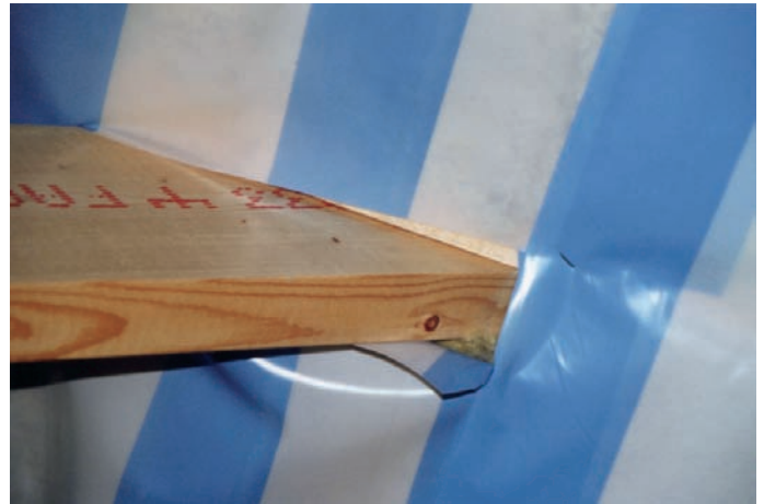
1 Dachgeschosse mit Kehlbalckenlage weisen eine Vielzahl von Durchdringungen auf, eine fachgerechte Abdichtung ist wirtschaftlich nicht möglich.
