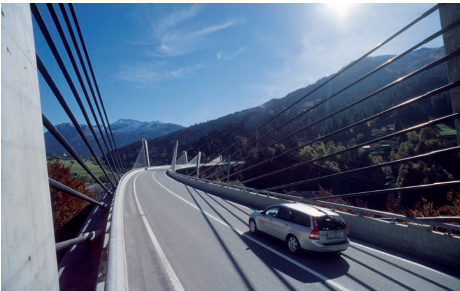
Die Brücke Sunniberg, als Teil der Ende 2005 eröffneten Umfahrung von Klosters, schwingt sich leicht und elegant über das Tal und die Landquart. (Foto: Tiefbauamt Graubünden)
