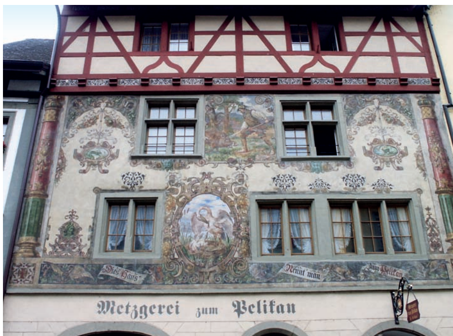
Das Haus zum Pelikan nach der Erneuerung in den 1990er-Jahren.
