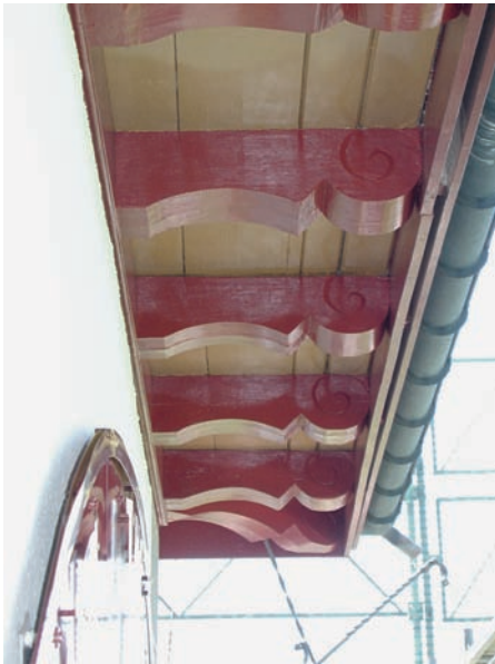
Sämtliches Holzwerk an der Kirche wurde mit Ölfarbe gestrichen. (Foto: architekten:rlc ag, Rheineck)
