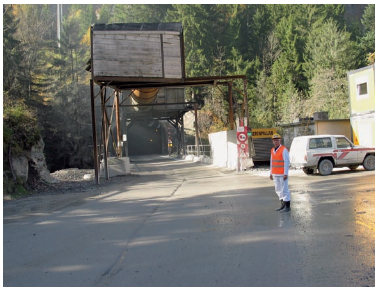
Walter Rösch vor dem Einstieg in den Lötschberg-Basistunnel an der Baustelle Mitholz.
