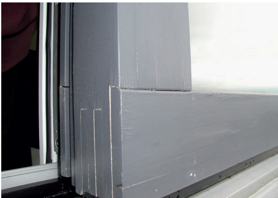
1 Beim Einsatz von Holz geschehen immer wieder Fehler, die zu Schäden führen, wie hier an der Eckverbindung eines Holzfensters.
