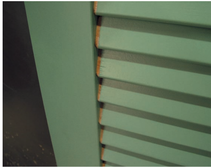
3 An dieser Terrassentür führte das Quellen und Schwinden infolge Feuchtigkeitswechsel dazu, dass unbeschichtetes Holz zum Vorschein kam.
