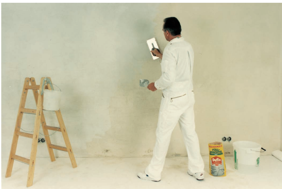
Eine vollflächige Spachtelung ergibt einen glatten Untergrund.
