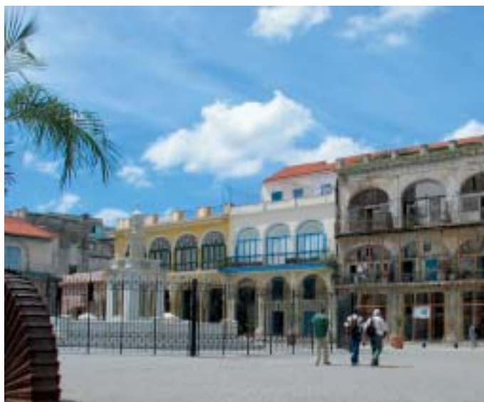
Reizvoller Kontrast zwischen renovierten und ursprünglichen Fassaden.
