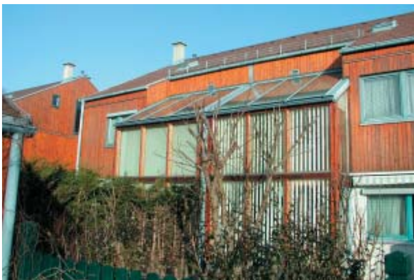
4 Reihenhausanlage, Baujahr 1988 Südseite. Erstbeschichtung und erster Wartungsanstrich (1996) mit brauner Lasur.
