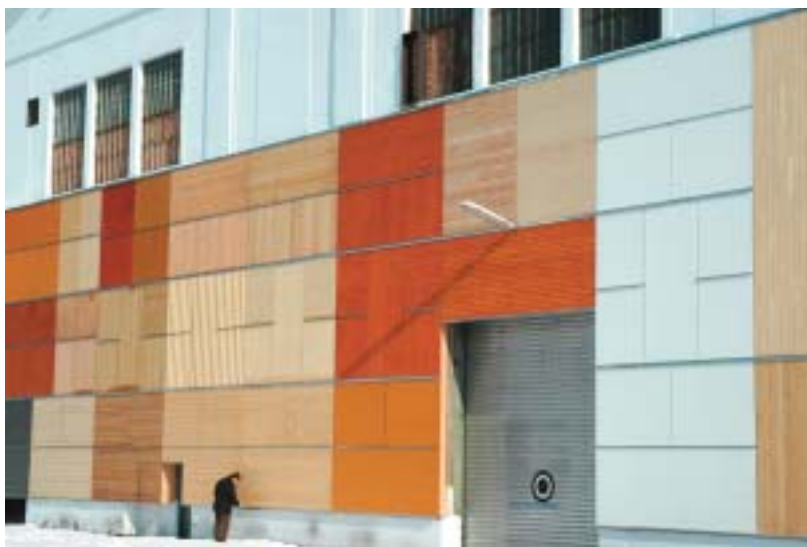
6 Acht Meter hoch und dreissig Meter breit ist die Forschungsfassade der Holzforchung Austria in Wien. Dort können 25 verschiedene Fassadenelemente über einen mehrjährigen Zeitraum begutachtet werden.
