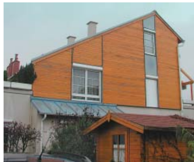
5 Reihenhausanlage, Baujahr 1991, Westseite. Erstbeschichtung mit brauner Lasur; Renovierungsanstrich (2000) mit hellbraunem Decklack und Maserierungsanstrich mit Lasur.
