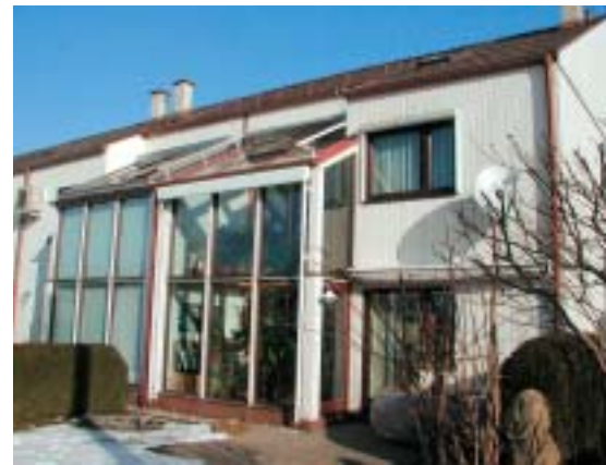
3 Reihenhausanlage, Baujahr 1986, Südseite. Erstbeschichtung mit grauer Lasur; 1996 Wartungsanstrich mit deckendem weissem Lack.
