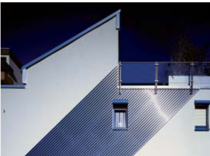
3 Metallische Fassadenteile verleihen einem Gebäude einen modernen Akzent.
