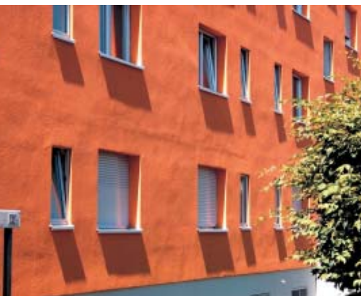
5 Im Streiflicht treten wellenförmige Abzeichnungen bei praktisch allen verputzten Aussenwärmedämmsystemen und allen konventionell verputzten Fassadenflächen auf und müssen normalerweise akzeptiert werden.
