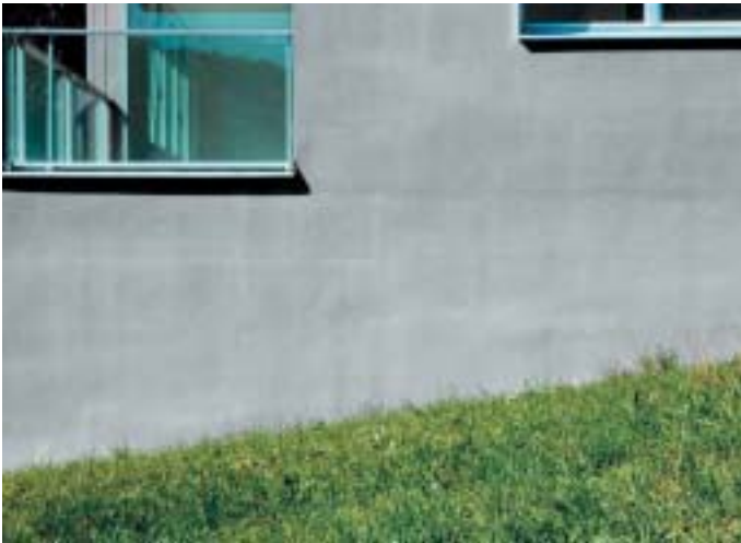
2 Abzeichnungen im Sockelbereich infolge zu hoch geführter XPS-Platten sowie des verwendeten bituminösen Klebemörtels.
