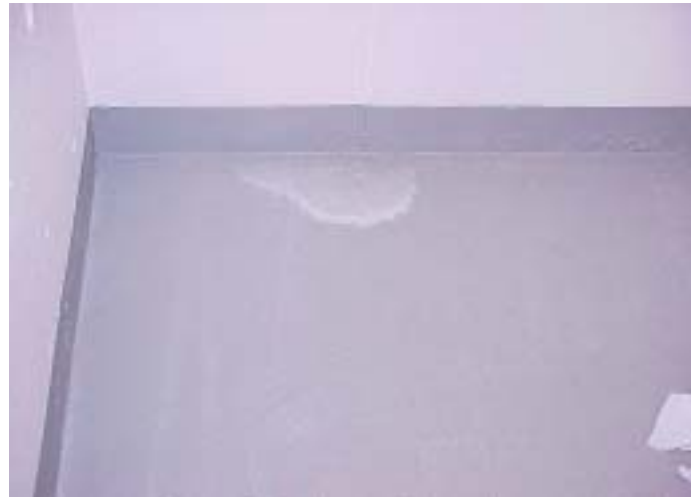
Eine ungenügende Luftzufuhr führt nach dem Aufbringen wasser- verdünnter Bodenversiegelungen häufig zu Kondensatbildung.
