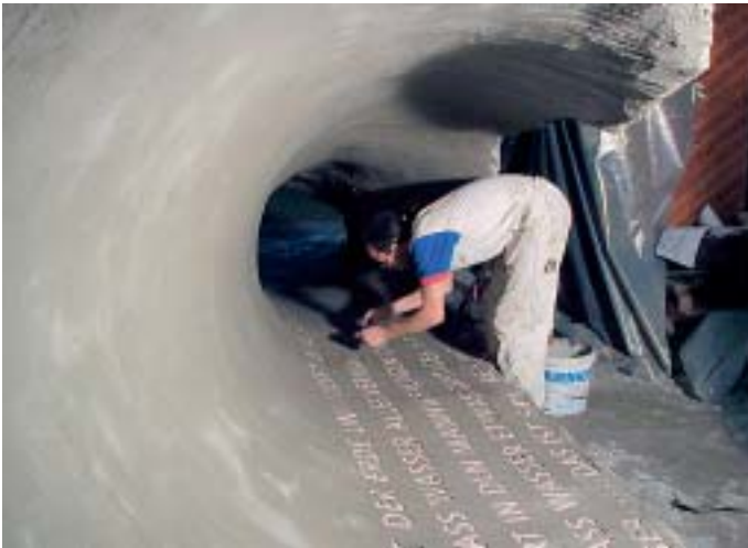
Das Sgraffito-Schriftband wird rund um die «Welle» im Sockelbereich angebracht.
