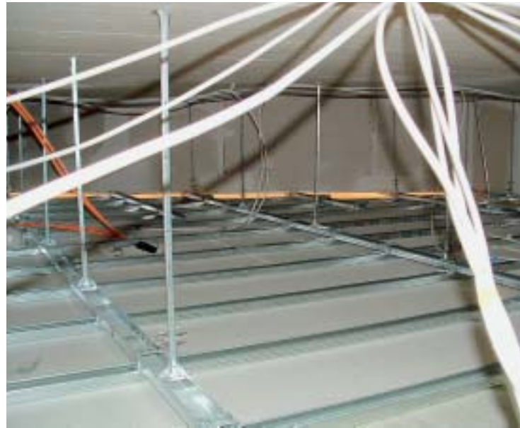
Metallunterkonstruktionen verändern ihre Länge unter Feuchteinfluss nicht, Gipsbauplatten aber schon. Fehlen Dehnungsfugen, können die entstehenden Spannungen zu Rissen führen.
