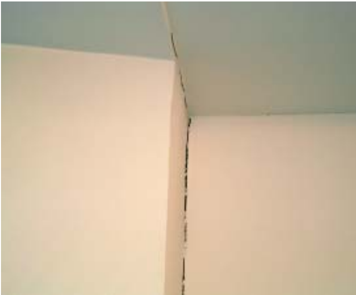
Risse, die so breit sind, stammen nicht allein aus Spannungen in Gipsbauplatten, sondern deuten auf Bewegungen der Gebäudehülle hin.
