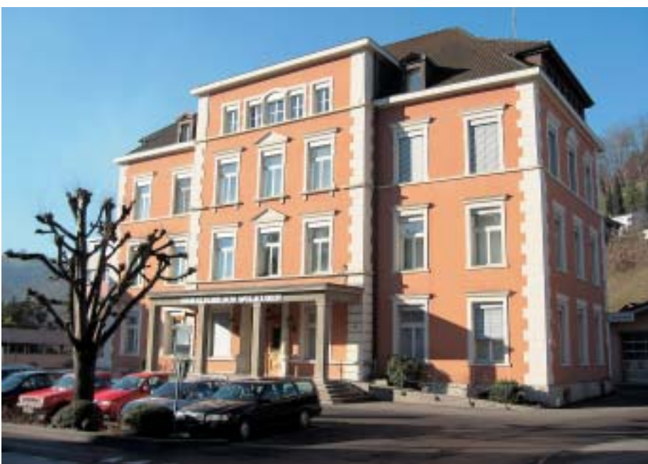
Silikatfarben haben gemäss einer 1996 durchgeführten Studie die bessere Ökobilanz als Silikonharzfarben. Im Bild eine Aufnahme des Gemeindehauses Wolhusen LU von 2005, das 1976 mit Organosilikatfarbe gestrichen wurde.
