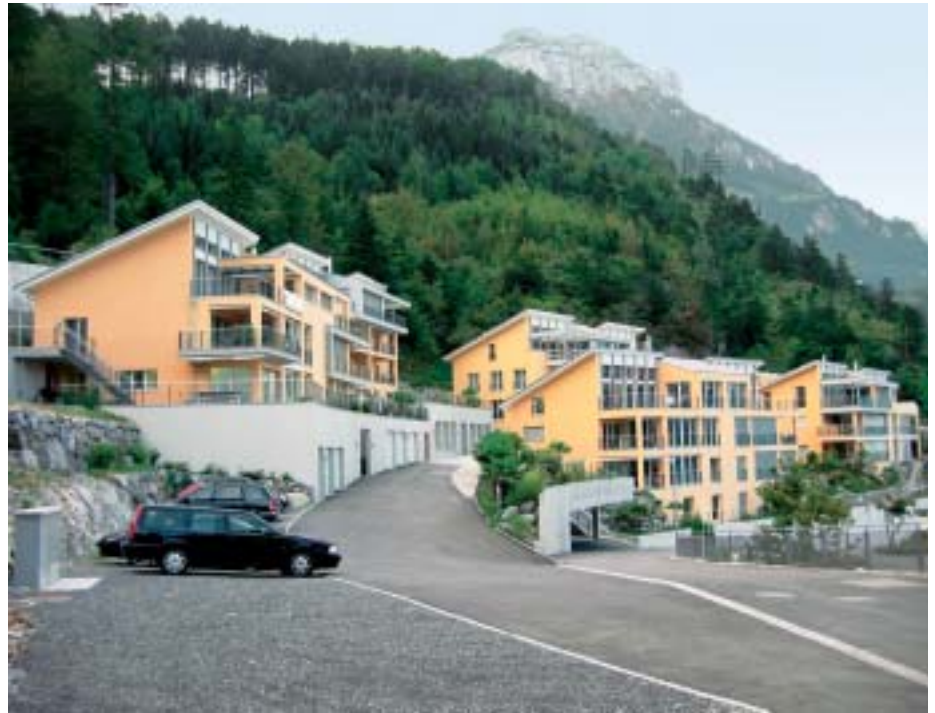
Eine nach ökologischen Grundsätzen gebaute Mehrfamilienhaus-Siedlung in Brunnen SZ, die 2001 in halbdeckender Technik mit Silikatfarbe gestrichen wurde.
