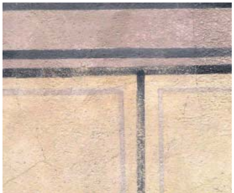
Die stark bewitterte Westseite der Münchner Residenz, des Wohn- und Regierungssitzes der früheren bayerischen Herzöge und Könige, zeigt auch 48 Jahre nach der Beschichtung mit Reinsilikat-Lasuren eine problemlose Oberfläche – trotz Rissen in Putz und Anstrich.
