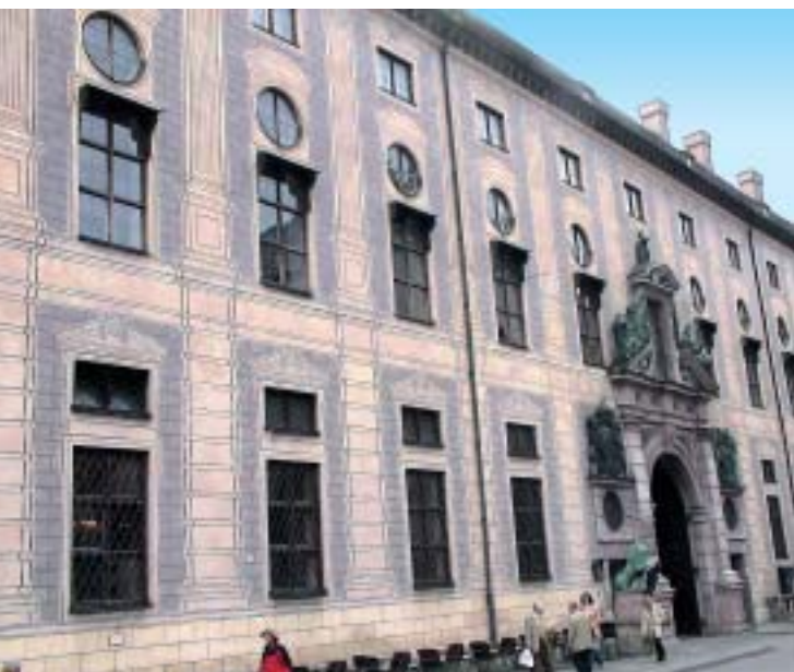
Die stark bewitterte Westseite der Münchner Residenz, des Wohn- und Regierungssitzes der früheren bayerischen Herzöge und Könige, zeigt auch 48 Jahre nach der Beschichtung mit Reinsilikat-Lasuren eine problemlose Oberfläche – trotz Rissen in Putz und Anstrich.
