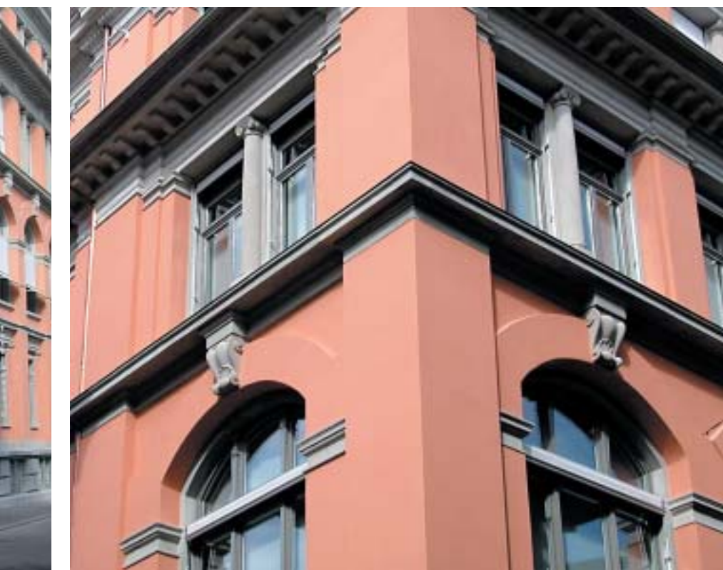
Die zweiteiligen Fenster mit Sandstein-Einrahmungen in der zweiten Etage sind jeweils durch eine kurze ionische Säule voneinander getrennt.
