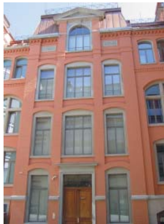
Die Hofseite des Gebäudes wurde nie verputzt, sodass immer noch das Backsteinmauerwerk zu sehen ist (Zustand nach der Renovation).
