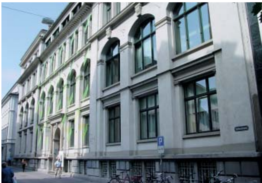
Die Fassade des Textilmuseums zeigte sich vor der Renovation in hellem Grau.
