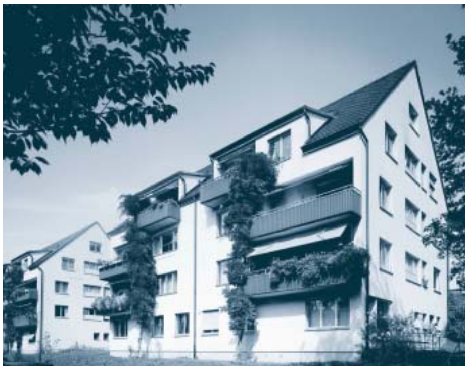
Dieses 1932 erbaute Mehrfamilienhaus in Zürich wurde 1974 zur reinen Rissüberbrückung mit einer 30-mm-Fassadendämmung saniert.
