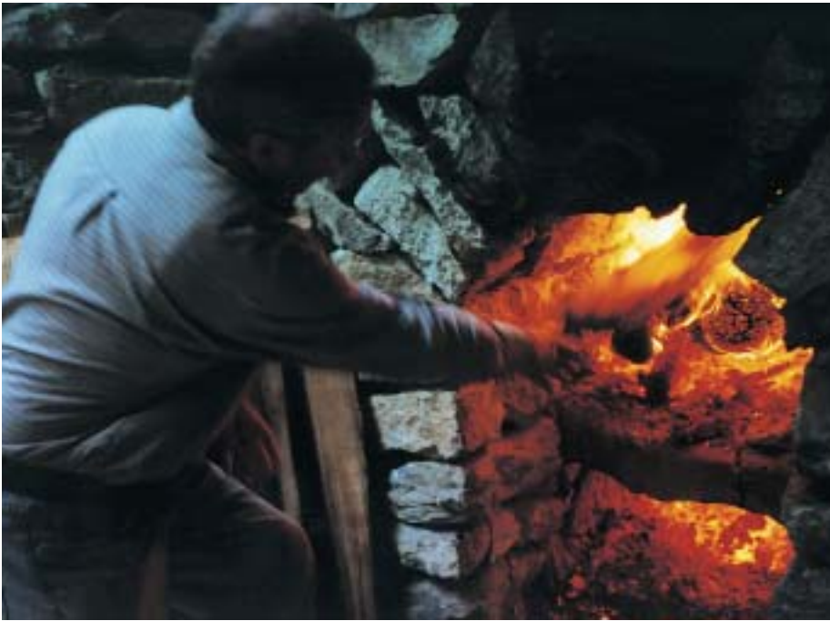
Kalk brennen auf dem Ballenberg. Das «Höllengefeuer» verschlingt Unmengen an Nahrung, bis die Kalkkammer mit den Kalksteinen auf eine Temperatur von 1100 bis 1200 Grad erhitzt ist.
