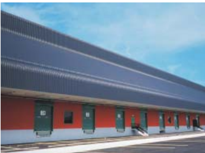
5 Farbe am Industriebau: Ein weisses Gebäude hätte «Löcher» in die Landschaft gerissen.
