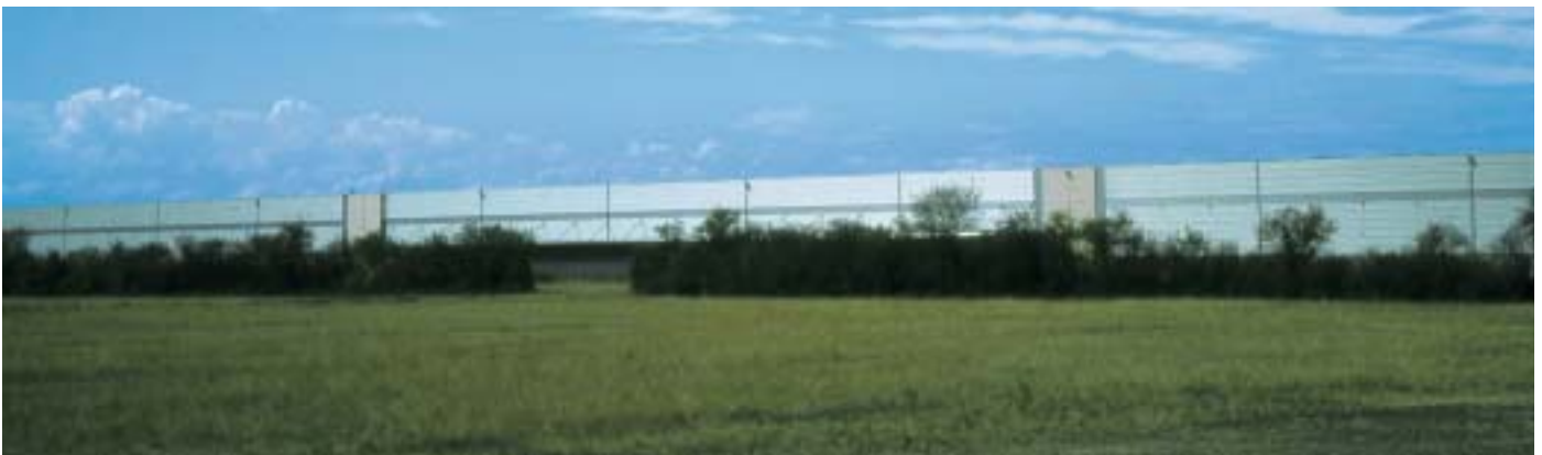
2 Das Licht- und Farbenspiel der metallisierten Fassadenoberflächen verleiht den riesigen Industriebauten attraktive Leichtigkeit.
