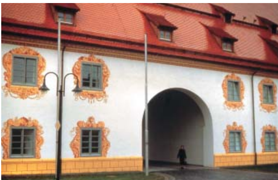
Klosteranlage Rot nach der Sanierung mit Sanierputz WTA und Bemalung mit reiner Silikatfarbe
