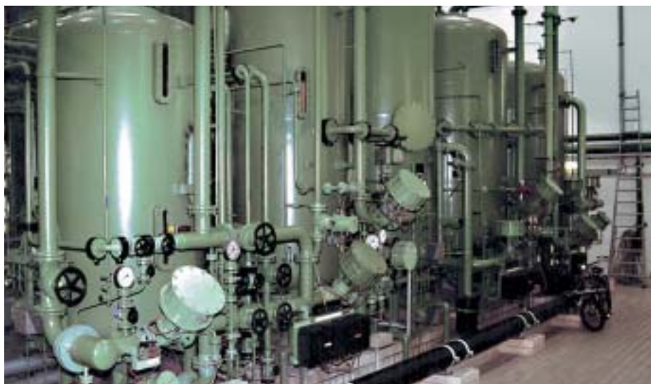
Kernkraftwerk Biblis, 1985: Feuchtstrahlen in Kombination mit noverox
