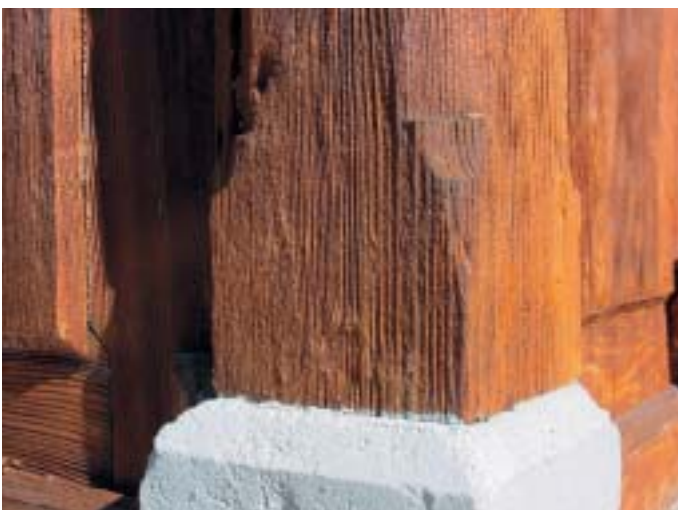
Detail wasserverdünnbare Lasur auf Alkydharzbasis nach acht Jahren Bewitterung. Ein insgesamt zufrieden stellendes Ergebnis
