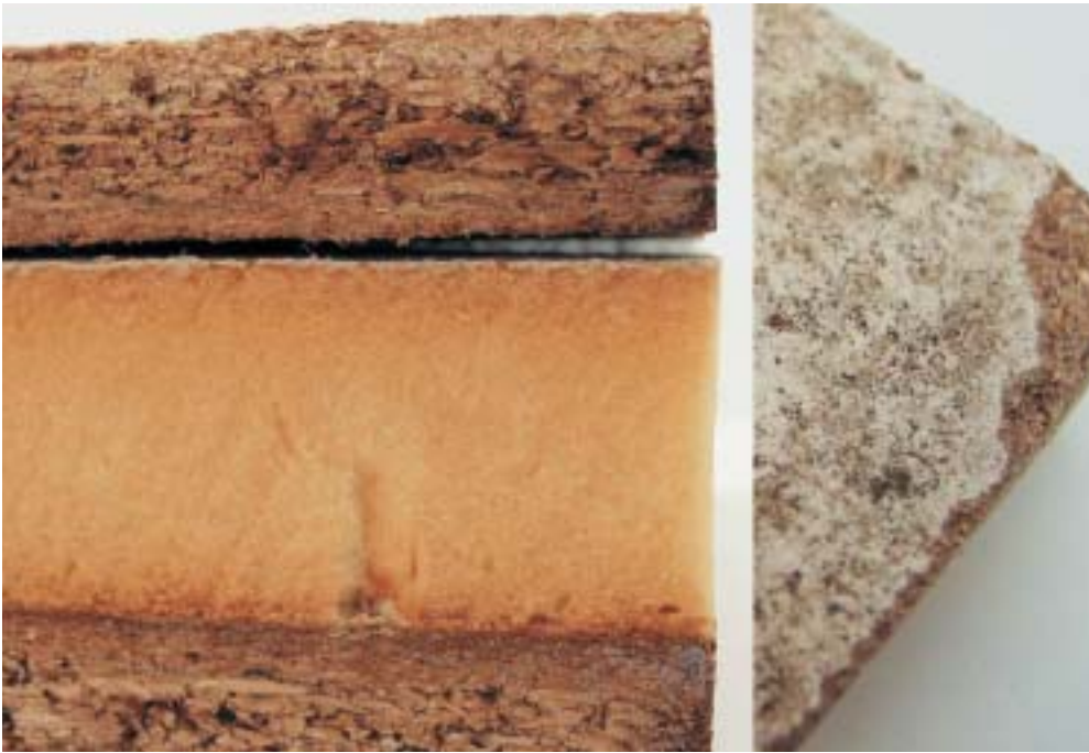
Spanplatten neigen stirnseitig zu starker Feuchtigkeitsaufnahme, was zu nachhaltigem Aufquellen führt. Durch ständige Feuchtigkeit kommt es an den Oberflächen auch zu Schimmelbefall (rechts)
