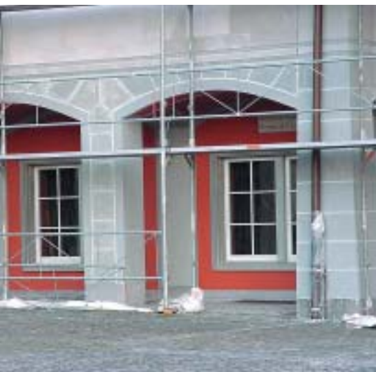
ndbögen in Architekturmalerei zusammengefasst
