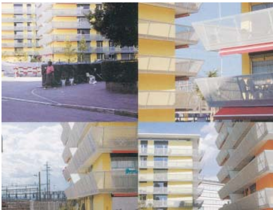
Die Balkonbrüstungen mit Lochblech dämpfen wie Filter die Farbeinwirkung
