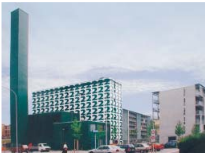
Anblick der Heizzentrale, von der Binzmühlestrasse aus gesehen
