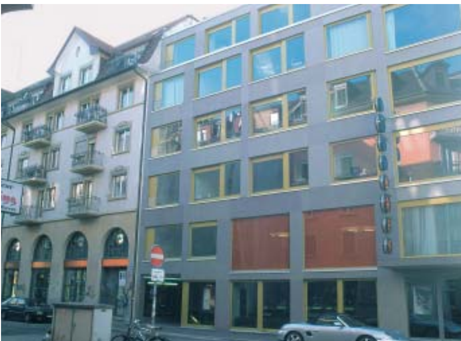
Optische Verbindung von Alt- und Neubau durch die Farbe Orange
