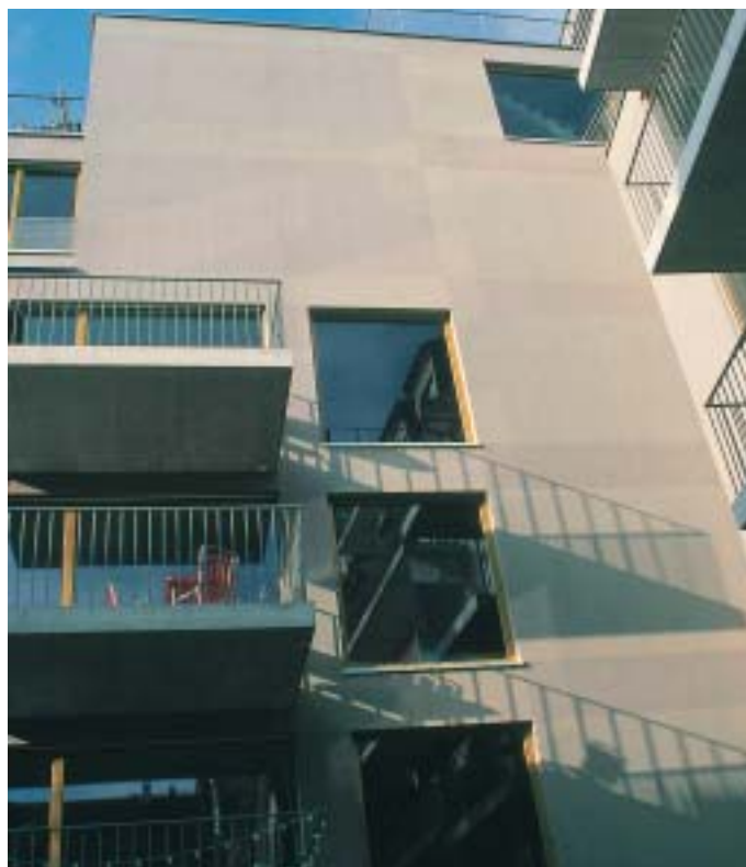
Horizontal und vertikal gebürstete Putzflächen
