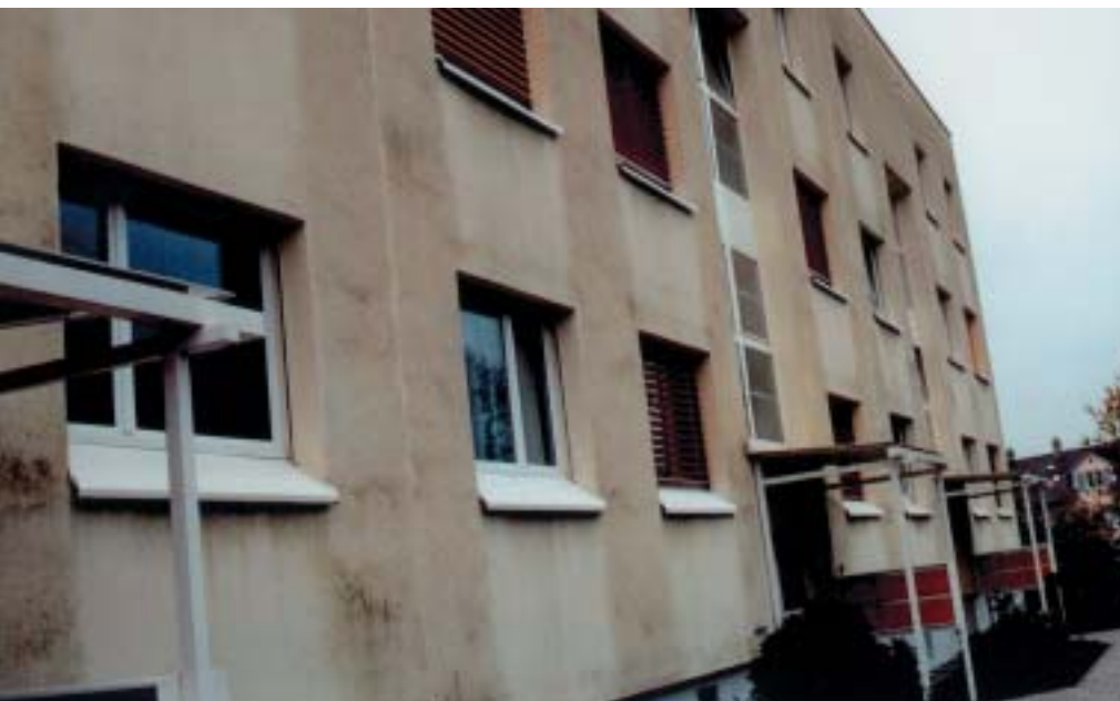
Wärmedämm-Verbundsystem mit eingefärbtem Deckputz, vier Jahre alt
